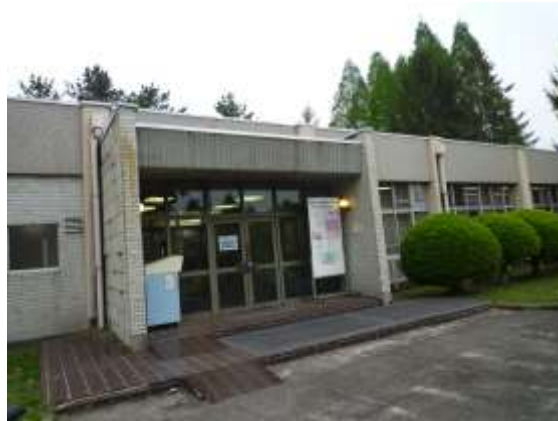
附属図書館分館 (建物の老朽化が著しい)
