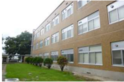
・峰町 2 号館（旧農学部 1 5 号館北棟）
