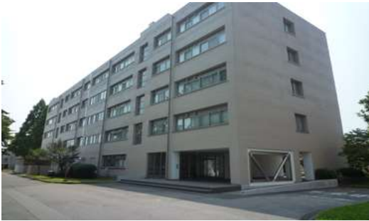
・工学部 8 号館（旧建設学科棟）
