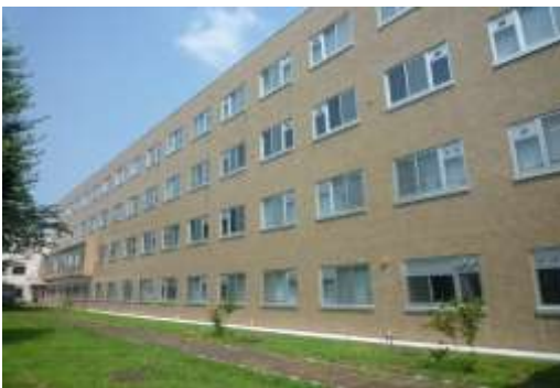
• 工学部 4 号館 (旧電気電子工学科棟)
