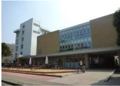
・峰町5号館（旧共通教育）B棟改修（その1）
